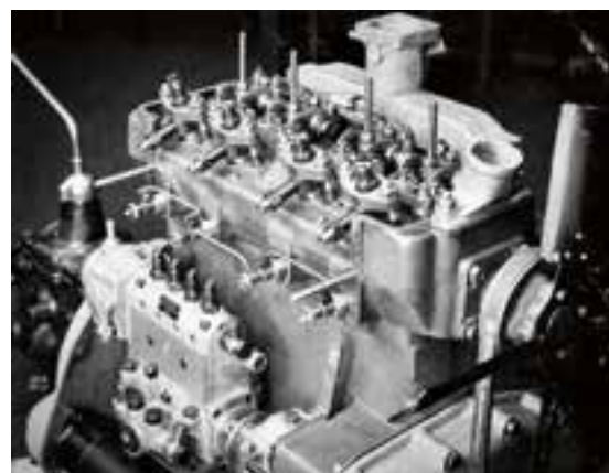
Padre de la criatura. Lazar Schargorodsky -arriba- preparó el motor diésel -abajo- de este cazarrécord, a partir del que previamente había desarrollado para la berlina Rekord.
